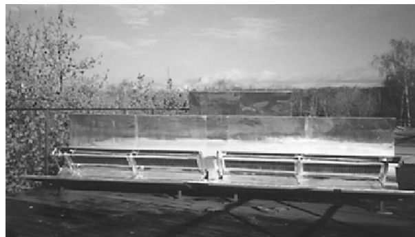
Рис. 2. Солнечная электростанция с параболоцилиндрическими стационарными концентраторами пиковой мощностью 1 кВт
