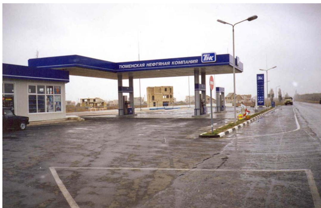
Рис. 8. Дорожная автозаправочная станция
